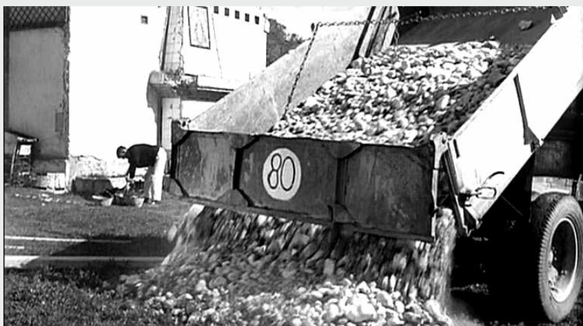
Fotograma. Descarga del camión
