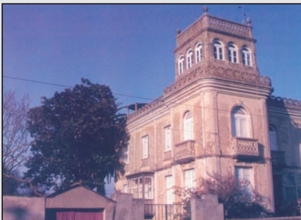
Casa-Torre de Maseda
