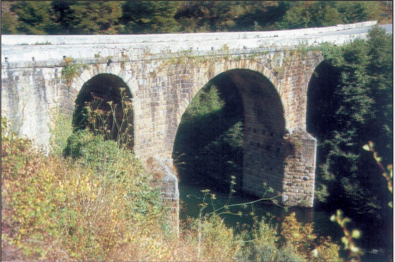
Puente sobre el río Bibeí
